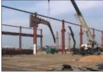
Elevar la carga a una altura suficiente para evitar obstáculos.
