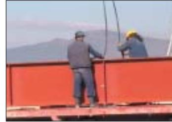
Tensor los cables una vez enganchada la carga.
