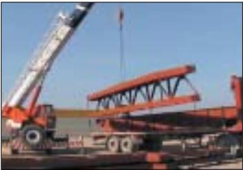
Si el despegue de la carga presenta una resistencia anormal, no insistir en ello y observar dónde está enganchada.
