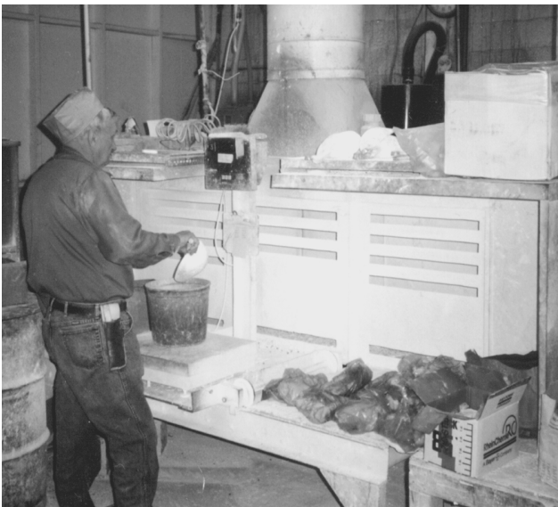
Figura 80.12 • Aspiración local en una estación de pesado de compuestos.
