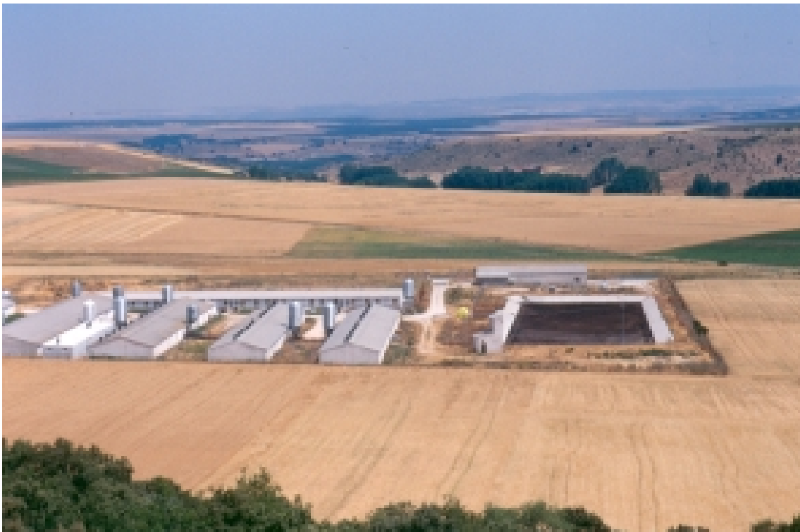
En el caso de las balsas de purines deben cumplirse estrictamente las condiciones establecidas en la correspondiente licencia de actividad.
