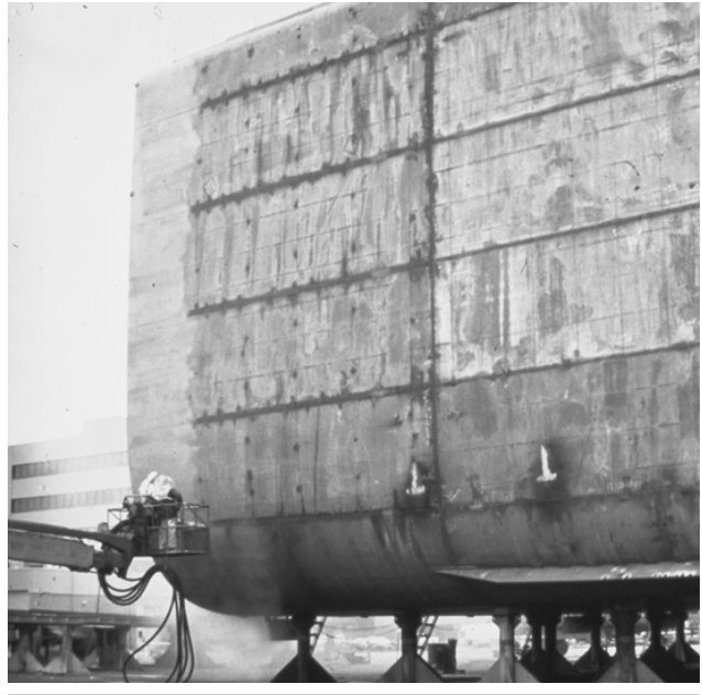
Figura 92.7 • Limpieza de barcos con chorro abrasivo antes de pintar.
