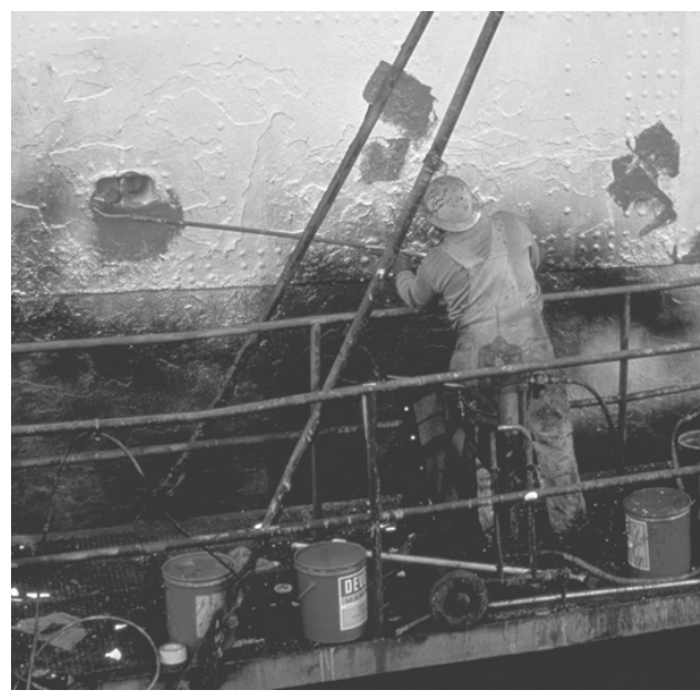
Figura 92.10 • Retoques de pintura en el casco de un buque.
