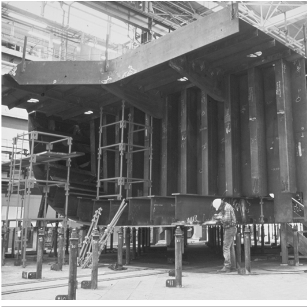
Figura 92.6 • Combinación de subconjuntos del buque en bloques mayores.
