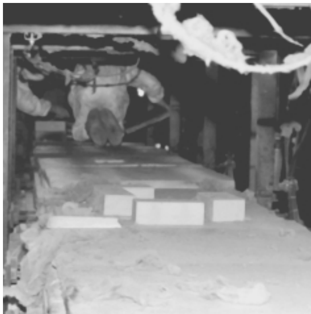
Figura 84.4 • Ingreso a espacios reducidos durante la reconstrucción del horno en una planta de fibra de vidrio. Una llovizna o vaho acuoso reduce las partículas en suspensión en el aire durante la demolición del horno.
